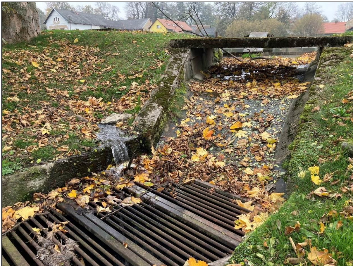
Obr. 7: Sdružený objekt je v havarijním stavu, proud vody ukazuje že podle betonové konstrukce rybník silně protéká a hladina proto v suchých obdobích zaklesá. Kolem 49°40'39.037"N, 15°41'14.117"E.
